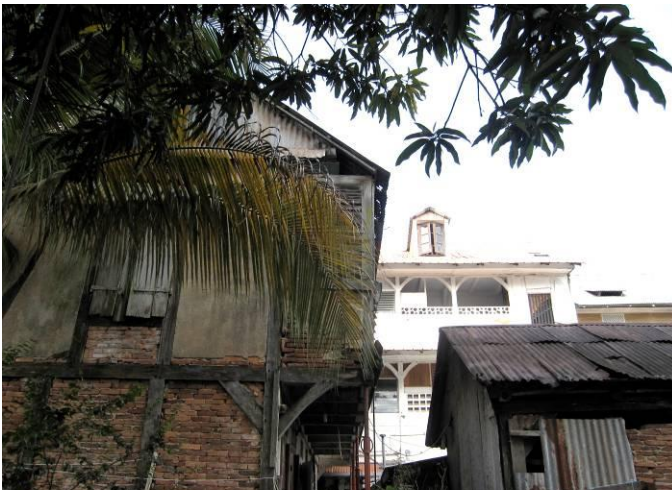
Cayenne, OPAH-RU du centre travaux en cours
